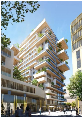
Tour ossature bois Bordeaux
