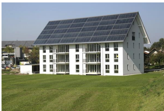
Immeuble de Jenni Energie technik à Oberburg/Burgdorf (Suisse)
