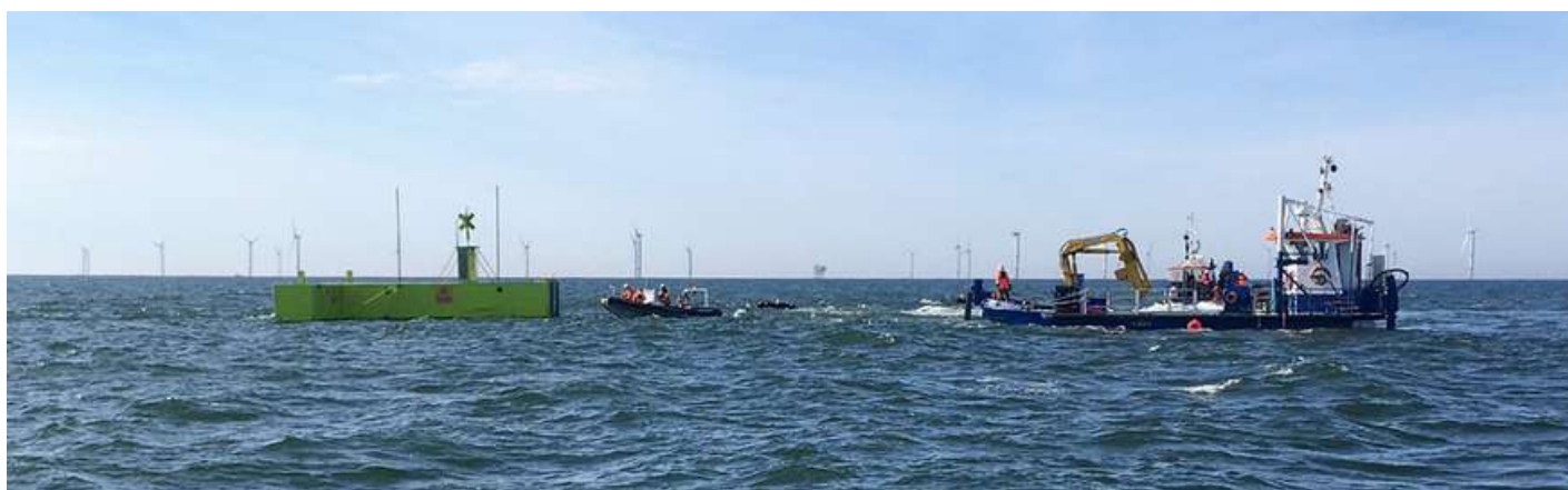
Installation du démonstrateur sur le site au large du Croisic
