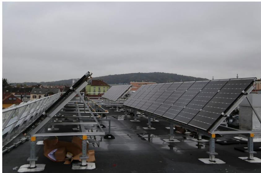
***Exemple d'installation sur un immeuble à Belfort : 39 panneaux et 2 PAC de 20 kW***
