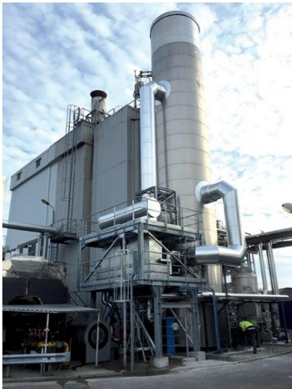
Laveur compact de flux gazeux : fumées de chaufferies, vapeurs de process, flux d'air...
